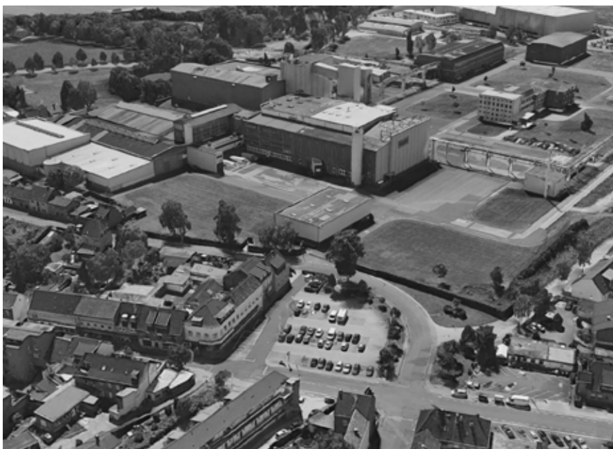
Schrägluftbilder der beschriebenen Untersuchungsgebiete
