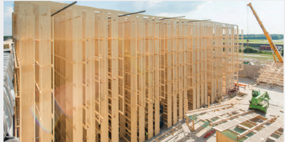
Logistikbauten aus Holz (Alnatura Logistikzentrum, Bickenheim)
